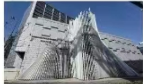
风塔 (现状, 后续改造为LED屏幕)
